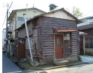
分譲当初のままの平屋建て住宅(空き家)
