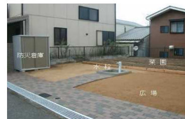
まちなか防災空地の事例 (兵庫北部地区)
