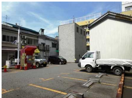
テラス化前の駐車場の様子
